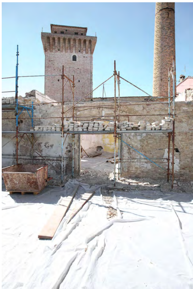
Figura 7. Durante il rifacimento delle coperture, ottobre 2019
