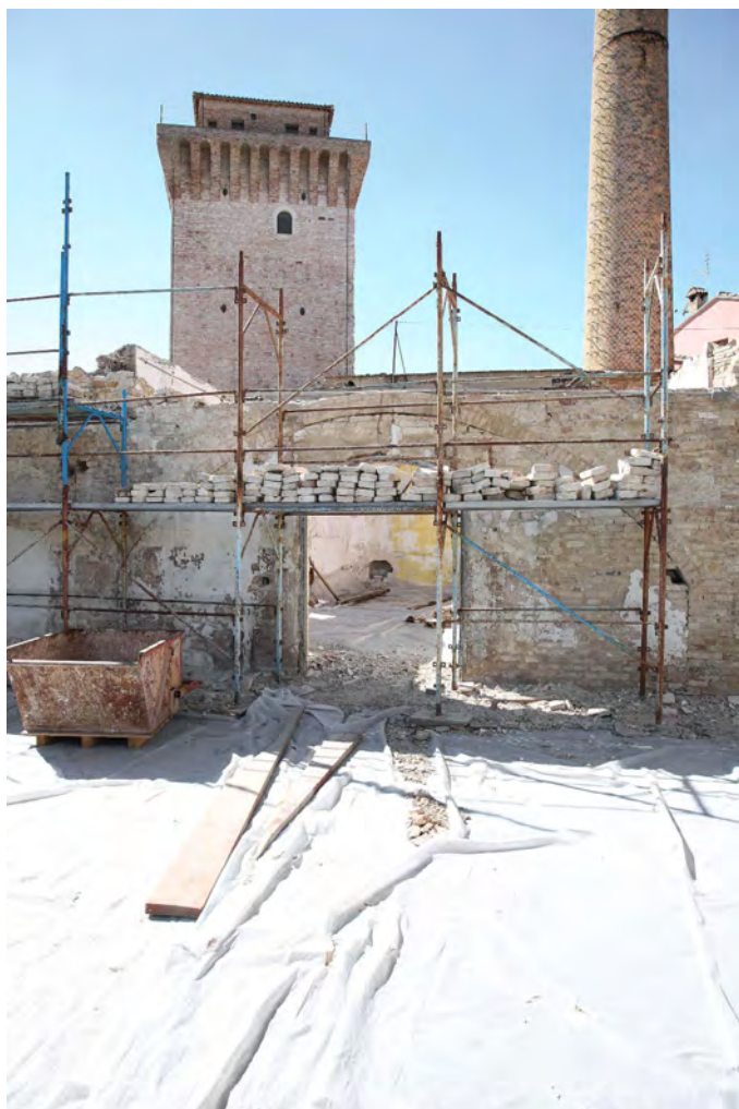
Figura 7. Durante il rifacimento delle coperture, ottobre 2019
