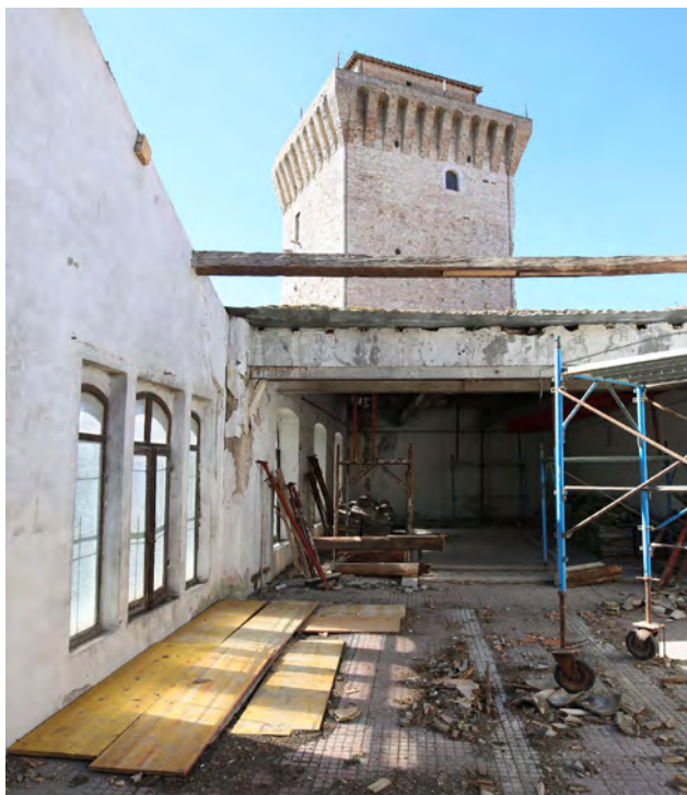
Figura 6. Durante il rifacimento delle coperture, ottobre 2019
