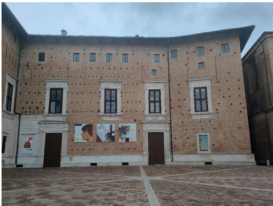
Fig. 5 Urbino, Palazzo Ducale, prospetto ovest della facciata ad ali (foto dell'autrice)
