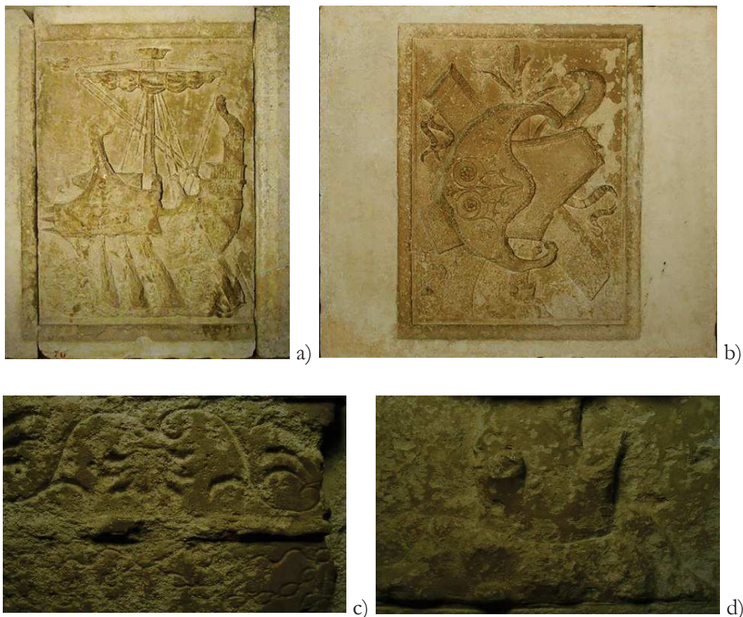
Fig. 14 Similitudini dello stato conservativo nelle formelle 42 (a, c) e 43 (b, d)
