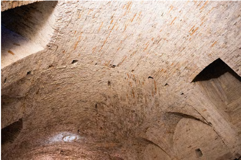
III 2.36 volta della stanza 1s.39 dove sono evidenti le riprese della muratura.
