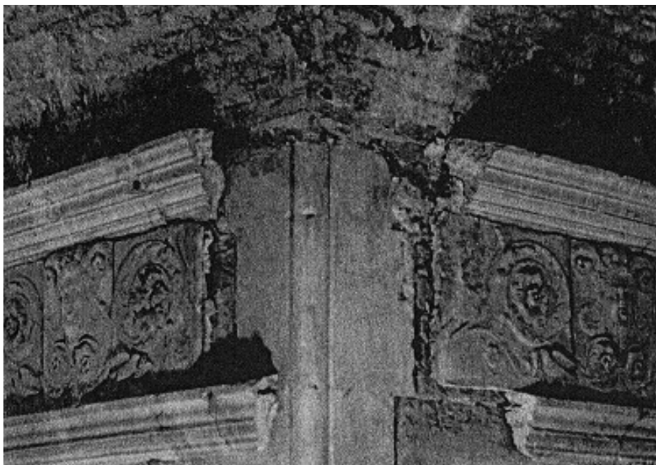
V 1.5 Il pilastro ad angolo delle soprallogge mostra le modifiche dovute alla decisione di cambiare la copertura piana con il tetto (biblioteca del Palazzo Ducale).
