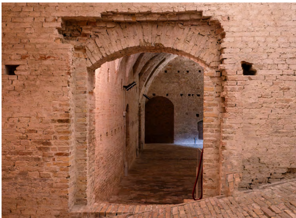
III 2.33 Fodera muro esterno lavanderia (1s.39), (foto Bastianelli).
