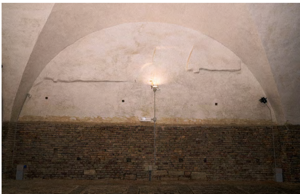
III 2.8 Muratura con blocchi spugnosi, parete sud della stalla del Castellare (1s.42) (foto Bastianelli).
