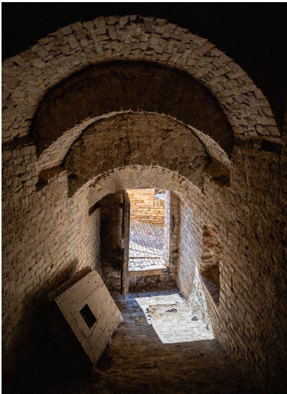
III 2.15 Secondo seminterrato: scivolo scarico rifiuti solidi (foto Bastianelli).
