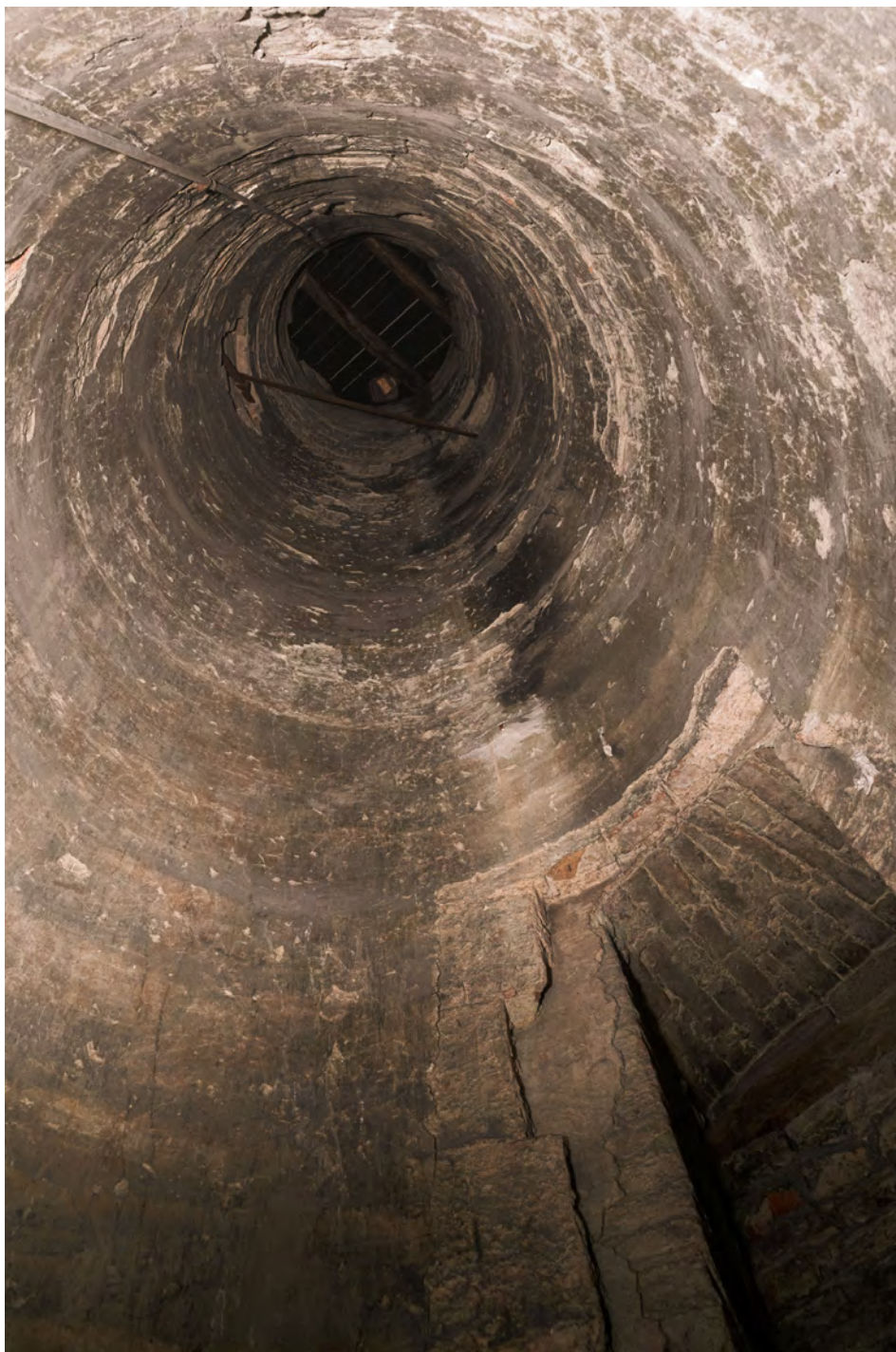
V 2.6 Cisterna realizzata nel cilindro della rampa del Castellare (foto Bastianelli).
