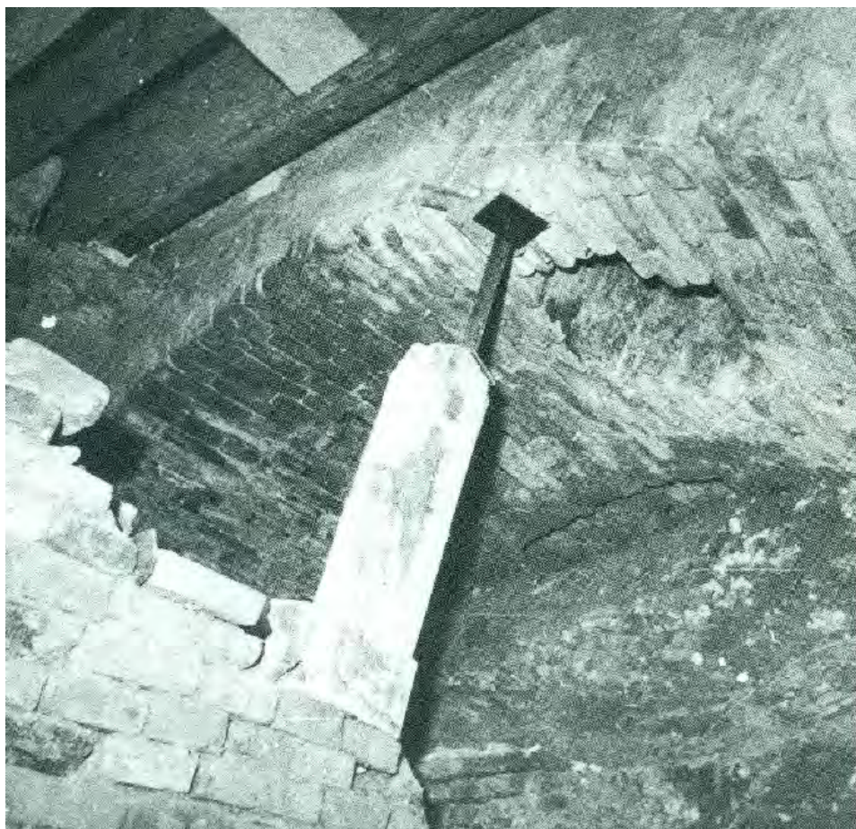
III 2.16 Arco che parte dal torricino NO impostato sul secondo sperone (da Polichetti 1985).
