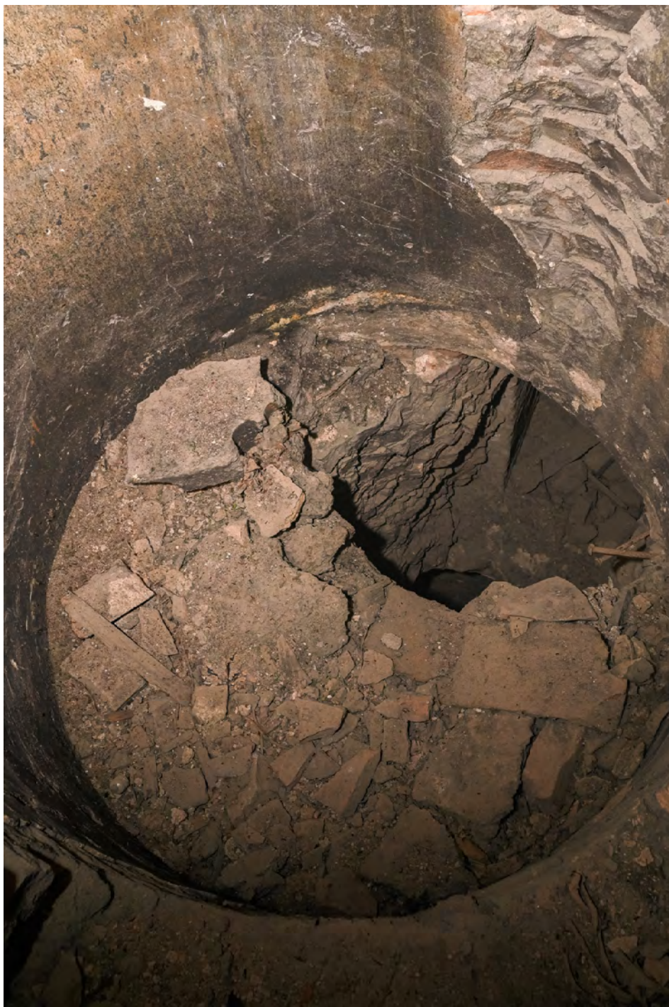
V 2.5 Fondo della cisterna (bucato per far passare una canna fumaria) realizzata nel cilindro della rampa del Castellare (foto Bastianelli).
